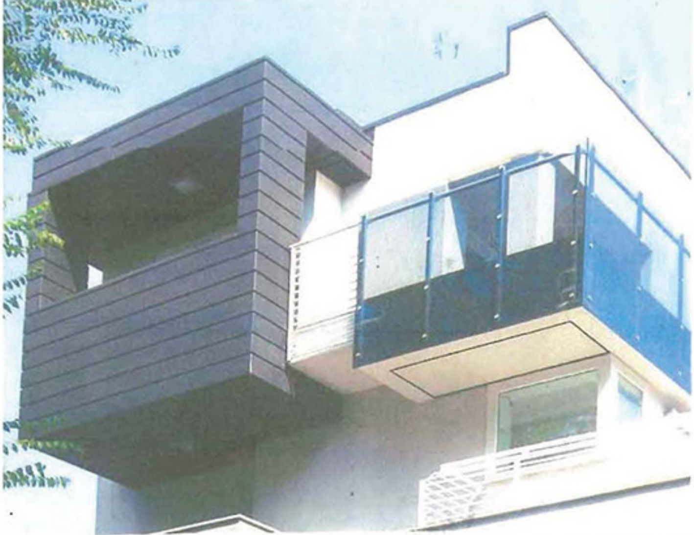
DETTAGLIO RIVESTIMENTO ESTERNO A DOGHE IN VMZinc
