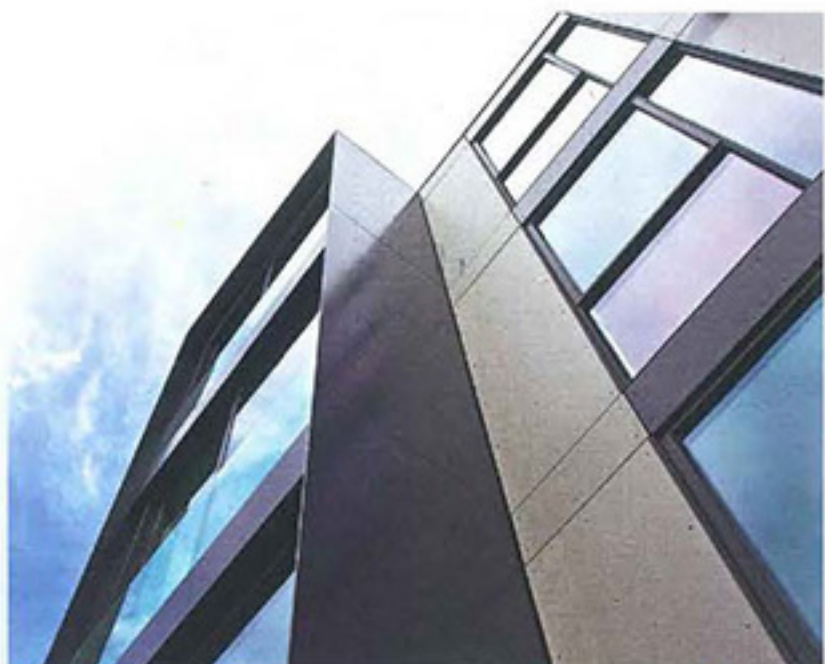
DETTAGLIO RIVESTIMENTO IN PANNELLI DI FIBROCEMENTO
