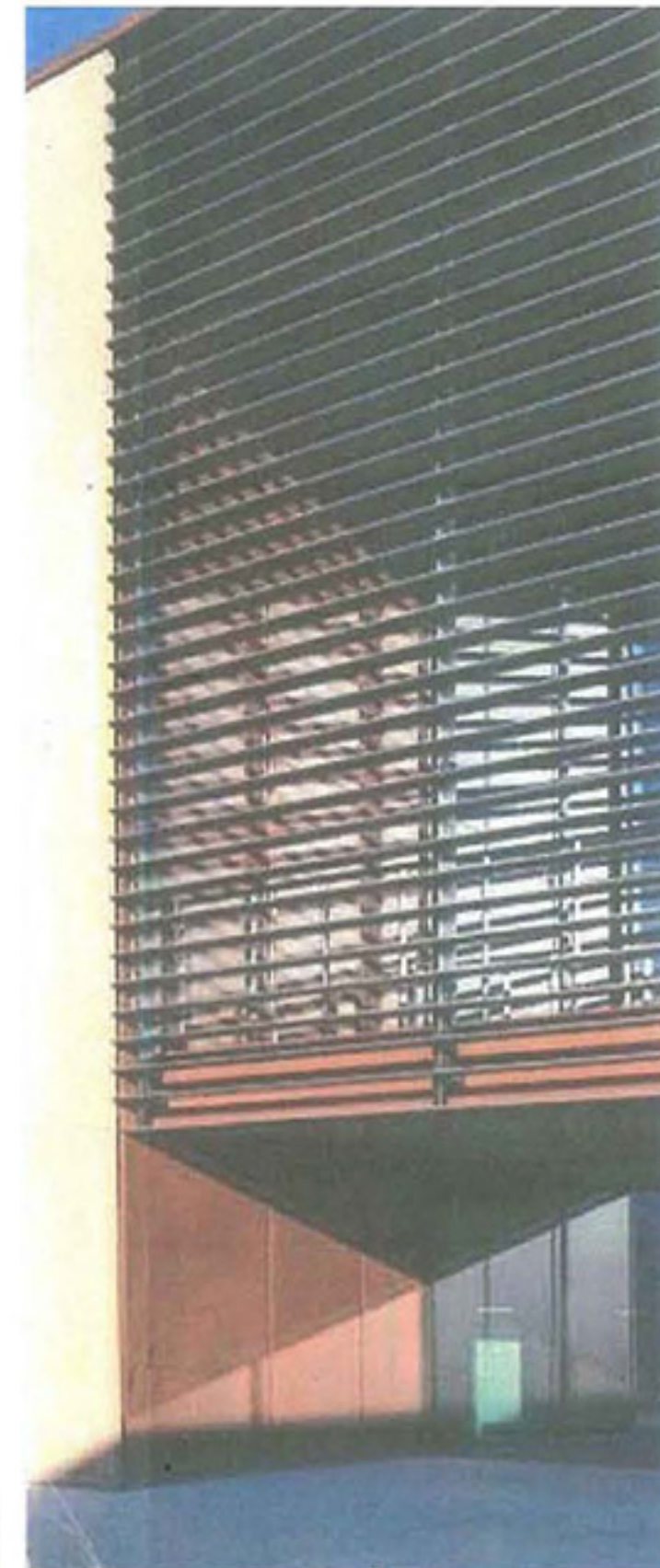
DETTAGLIO FRANGISOLE FISSO A LAMELLE ORIENTABILI IN VMZinc
