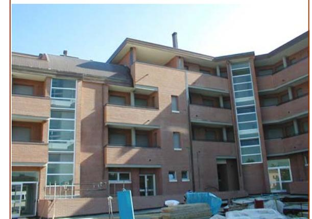
IL BALLATOIO INTERNO COME SOLUZIONE "ALTERNATIVA" NEL CORPO IN LINEA BASSO: EVITIAMO ANCHE IL SECONDO CORPO SCALA, REALIZZIAMO UN PERCORSO INTERNO SU VARIE ALTEZZE E SUPERILLUMINATO (NON È SOLO UN CORRIDOIO BUIO), RIUSCIAMO A PIEGARE L'EDIFICIO SECONDO LE DIREZIONI DETTATE DAL LOTTO, E NON DAGLI APPARTAMENTI
