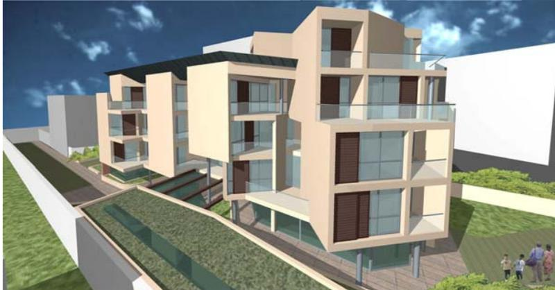
facciate trasparenti contenute in spalle cieche, saranno rivestiti con un intonaco a cappotto "sordo", un prodotto appositamente studiato e preparato per ottenere una superficie liscia e vellutata tipo cemento liscio, colorato in pasta con tinta "fredda" chiara.
