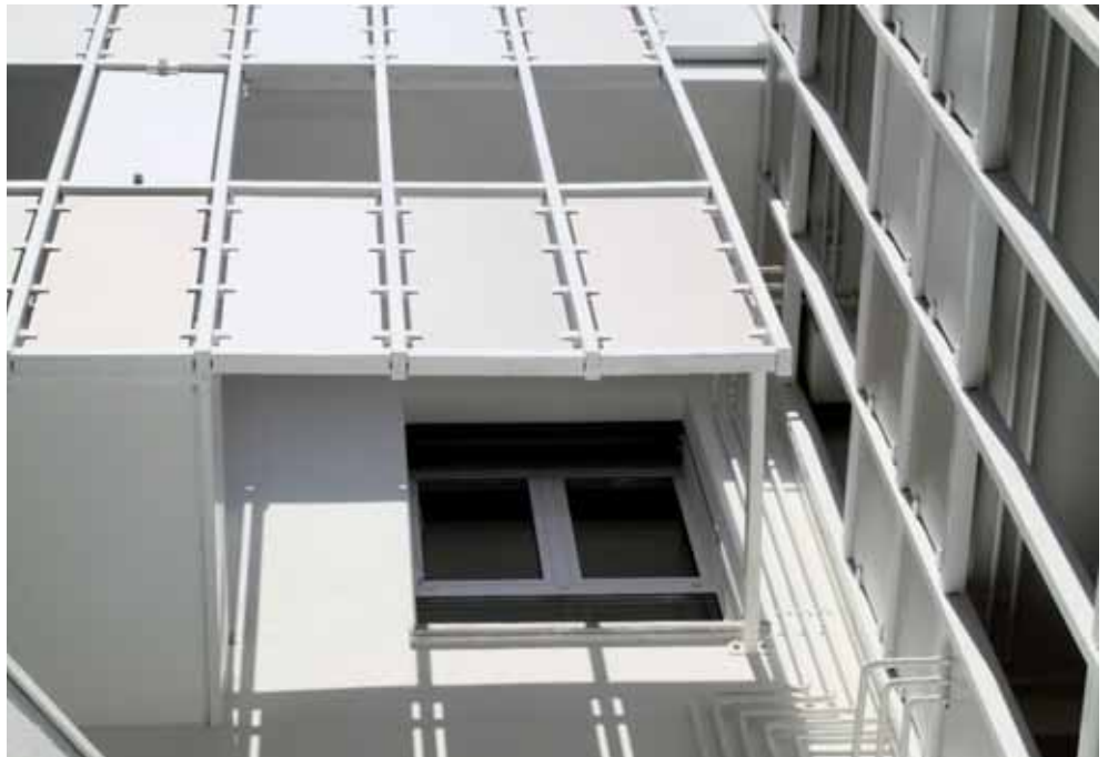
La corte interna: le facciate a pannelli su sovrastruttura in acciaio bianco uniformano i corpi ristrutturati
